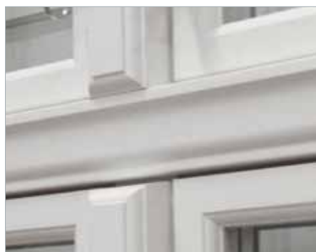
Gående lodpost under tværpost
