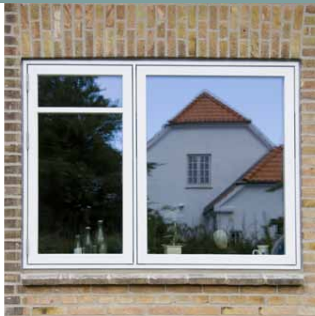
Karm/ramme-konstruktion som i 1960-1980'erne
