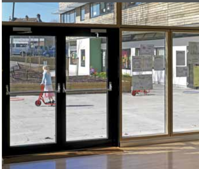
2-FLØJET FLUGTVEJSDØR MED PANIKGREB OG DØRLUKKERE I ET VELFAC 200 VINDUESPARTI
